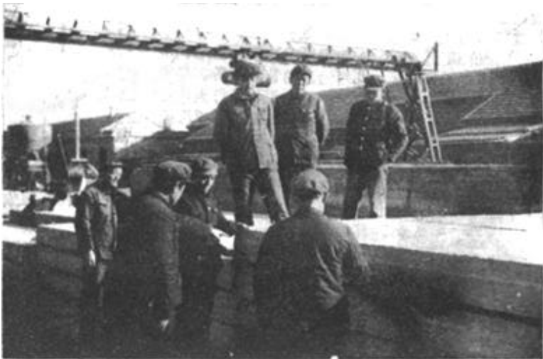
△惠民地区建筑公司第三工程处预制厂，注重产品质量，生产的大型屋面板质量全部达到设计规范，在东营地区同行业中名列前茅，受到了省质检小组的好评。图为有关人员在检查质量。（刘玉环）
